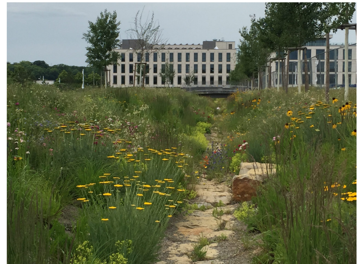
Artenreiche Verdunstungsrinne / Retentionsgraben Quelle: Landeshauptstadt Stuttgart, Garten-, Friedhofs- und Forstamt
