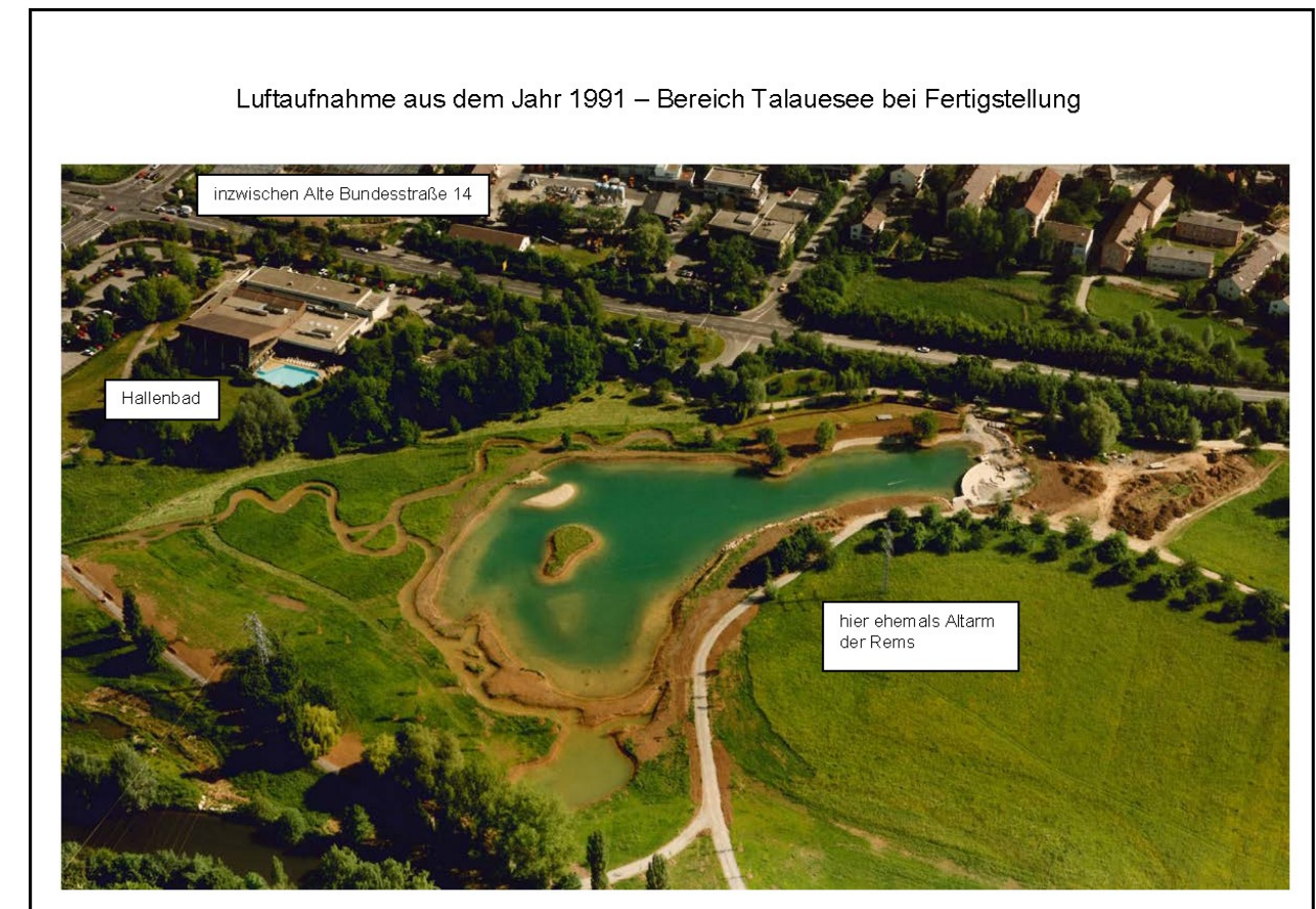
Zustand 1991 - Talauesee bei Fertigstellung Quelle: unbekannt / Archiv Stadt Waiblingen
