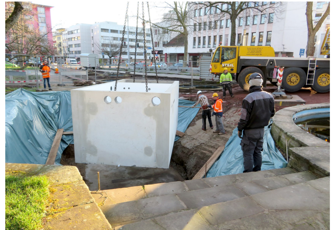
Einheben der Technik-Nasszelle Quelle: Andrea Jaekel
