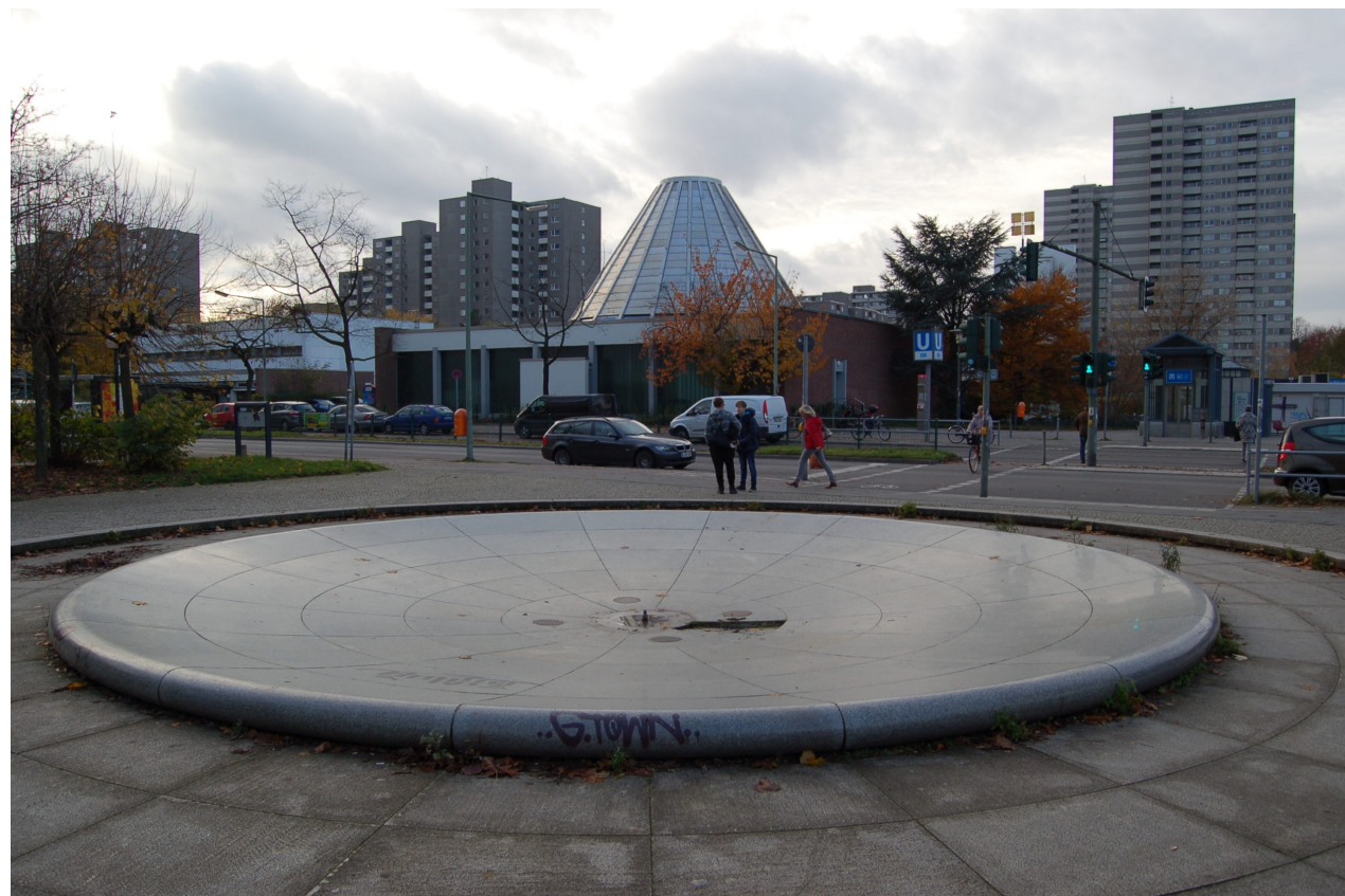
Lipschitzbrunnen vor der Sanierung
