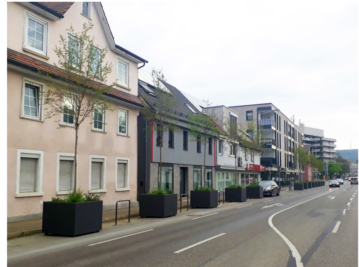
Neubau und Begrünung, Blick von Westen Quelle: Stadtplanungsamt Aalen
