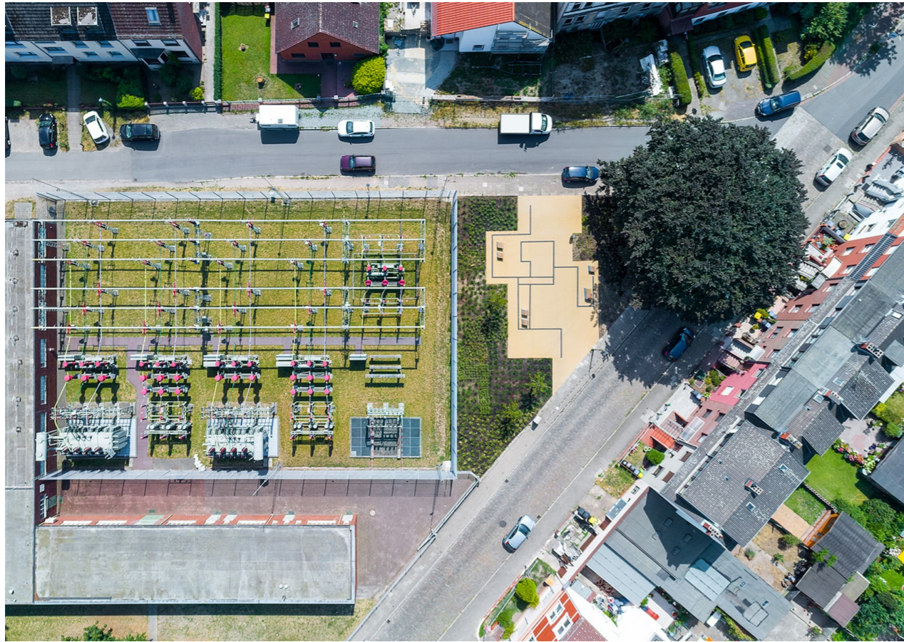
Willy-Hundertmark-Platz – Das Umspannwerk als Nachbar Quelle: UBB - Fotograf: Thomas Hellmann
